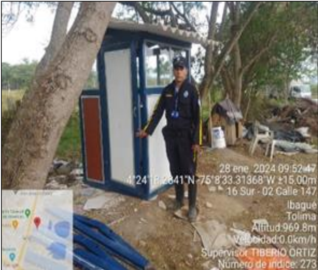
Anexo 11 Instalación de Caseta para el mejoramiento del bienestar del colaborador.
